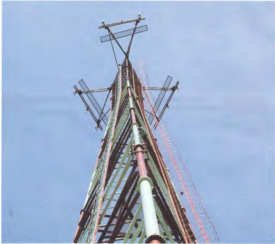
*Anexo # 6 figura # 7 Antenas para transmitir señales para teléfonos celulares*
